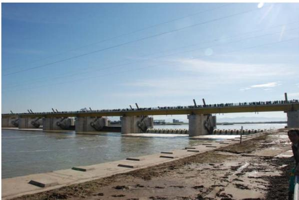
写真-5 通水した新可動堰
