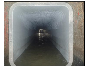
耐震対策後(管更生)
