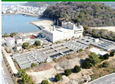
下水道事業(川の江浄化センター)
