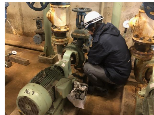
維持管理業者による修繕
