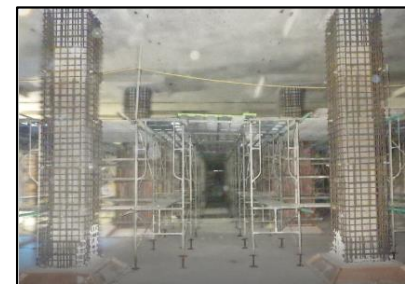
土木躯体の耐震補強
