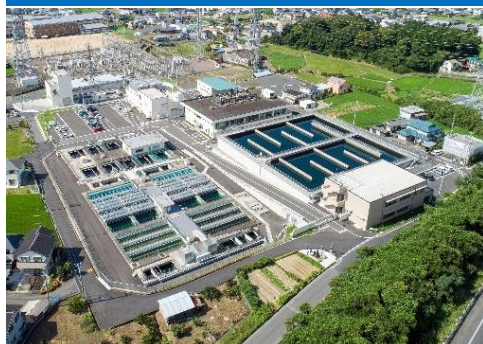
水道事業(中田井浄水場)
