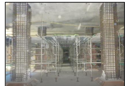
土木躯体の耐震補強
