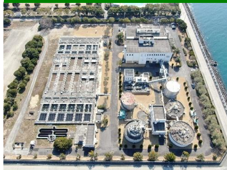
下水道事業(三島浄化センター)
