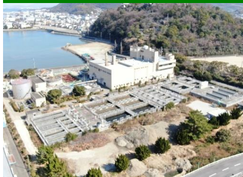
下水道事業(川の江浄化センター)
