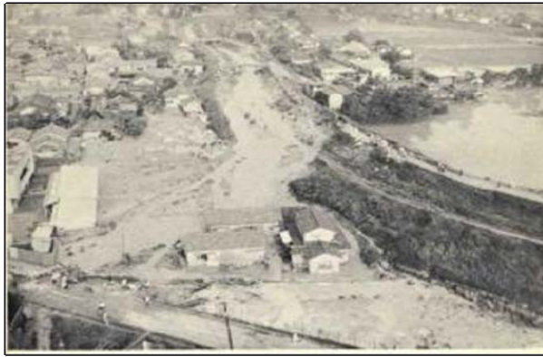
昭和 42 年 女瀬川の破堤
