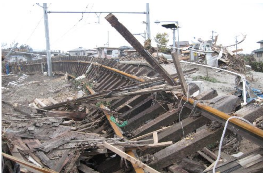
大きくねじ曲げられた線路（東名駅）
