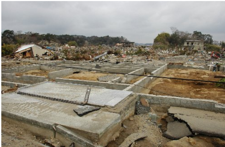
住宅のほとんどが基礎だけ残し流出
