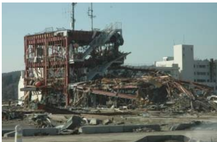
南三陸町防災対策庁舎
