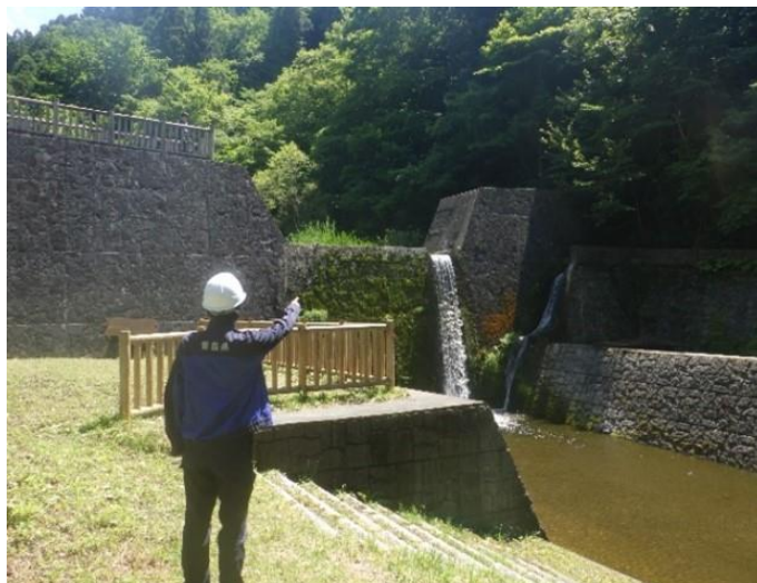
写真－5 深谷沢砂防堰堤設備点検（青森県中泊町）
