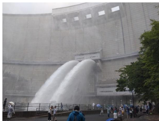
「2024(夏)温井ダム中位標高放流設備からの放流」 温井ダム：広島県安芸太田市
