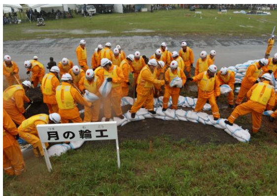
水防工法訓練（月の輪工） （第73回 利根川水系連合・総合水防演習）
