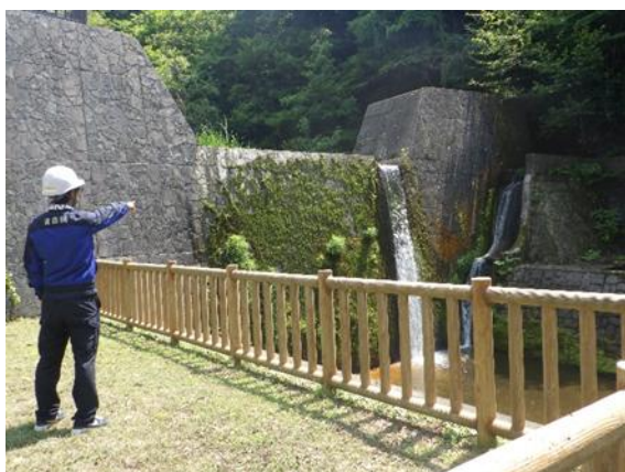
写真－5 深谷沢砂防堰堤設備点検(青森県中泊町)
