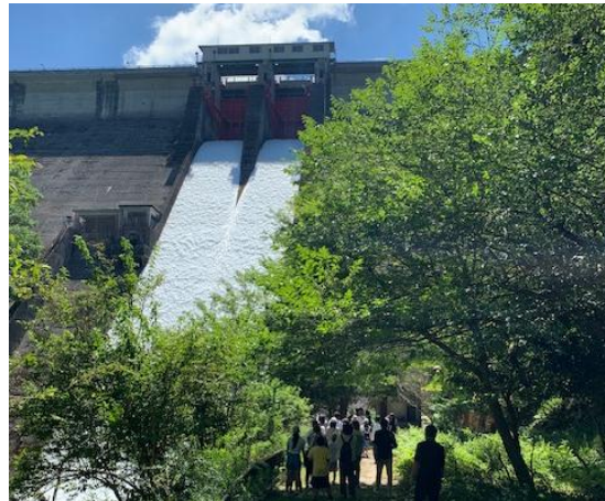
放流状況（引原ダム）
