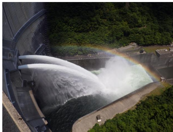
放流状況（温井ダム）
