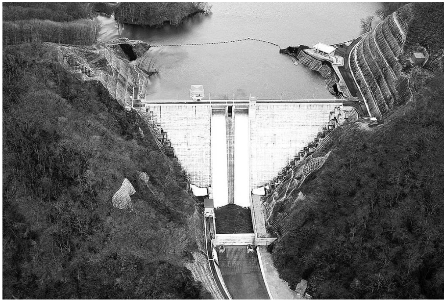
写真—3 砂子沢ダム航空写真
