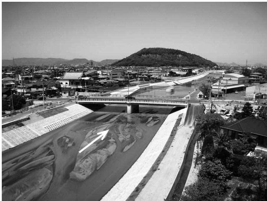
写真—5 完成した春日川激特事業（川島橋付近）
