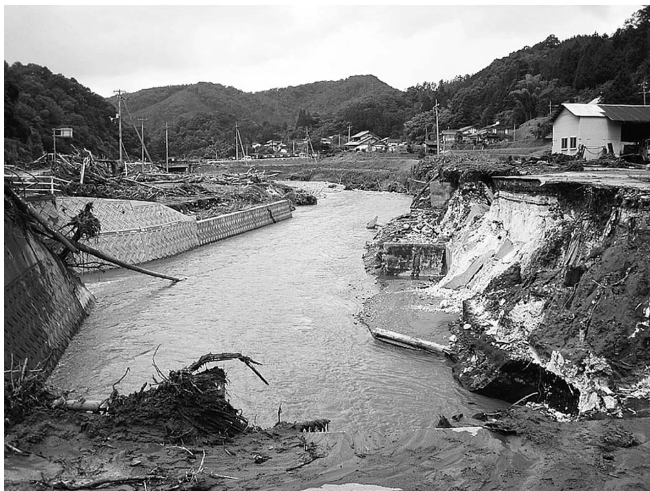
広島県庄原市川北地区の被災状況
