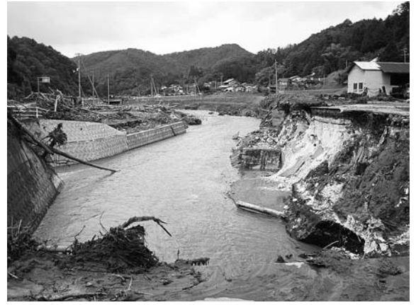
写真一〇 広島県庄原市川北地区の被災状況
