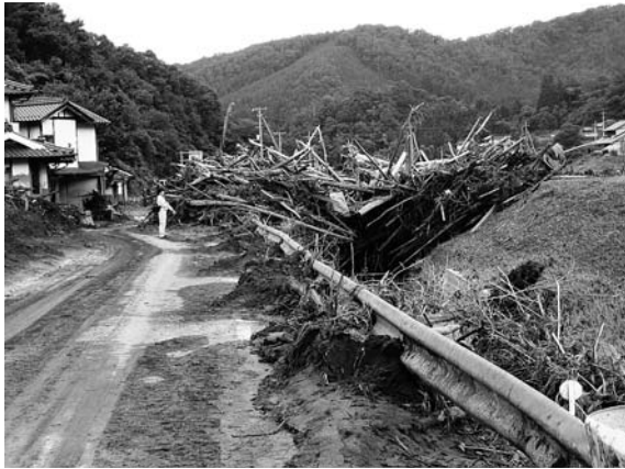
写真一八 広島県庄原市大戸地区の被災状況
