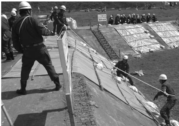
シート張り工 (総合防災訓練 in 熊本)
