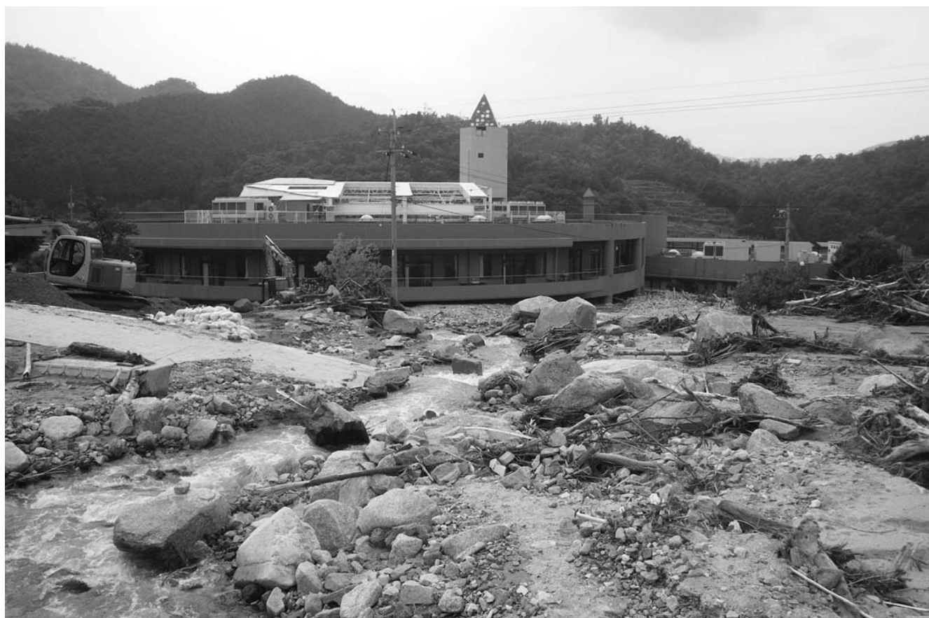
土砂災害 真尾地区 (山口県防府市)
