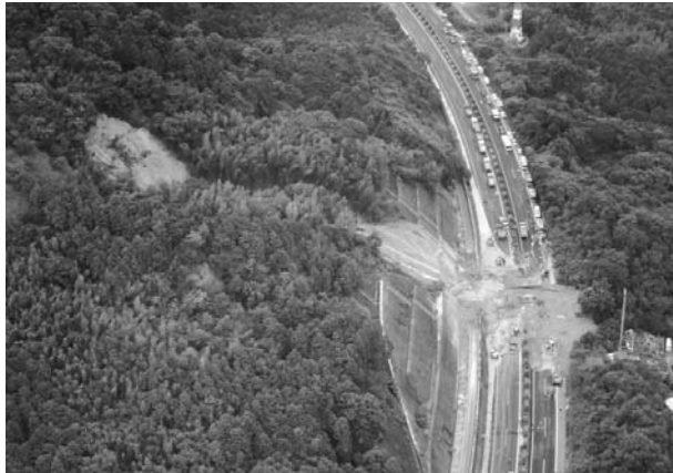
九州自動車道 (福岡県大野城市)
