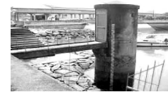
潮位計等の観測施設の設置
