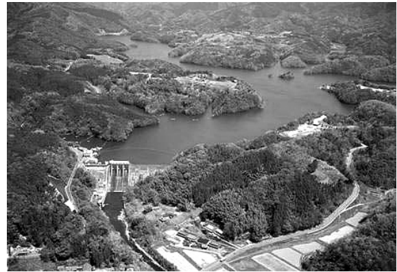
木屋川ダム現況写真
