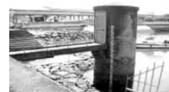
潮位計等の観測施設の設置
