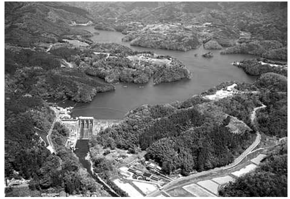
木屋川ダム現況写真
