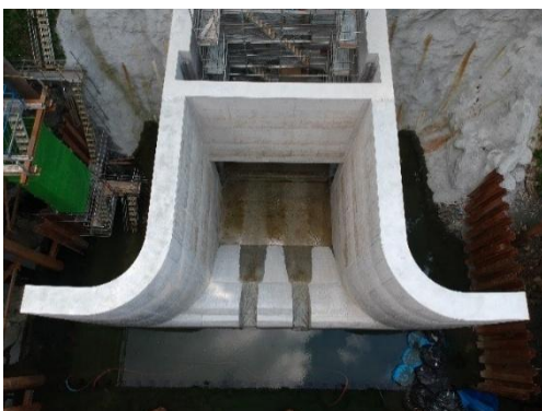
仮排水トンネル（転流工）完成状況
