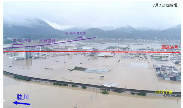
平成30年7月豪雨の洪水被害状況(大洲市東大洲)
