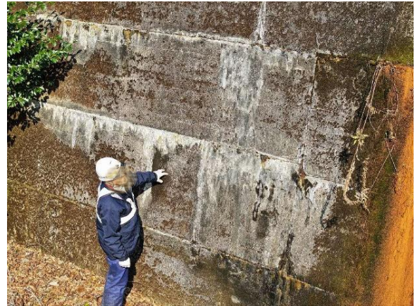
写真-6 斐伊川流域砂防堰堤設備点検(島根県雲南市)
