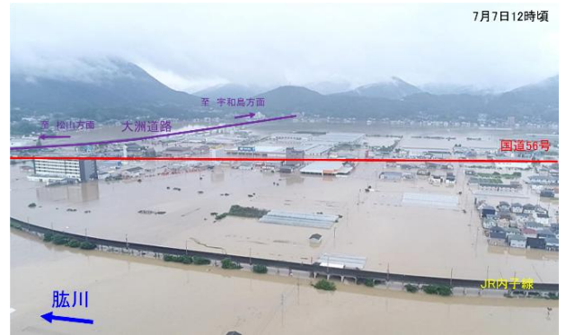
平成30年7月豪雨の洪水被害状況(大洲市東大洲)
