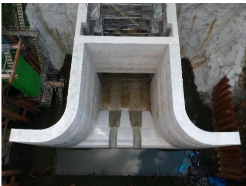
仮排水トンネル（転流工）完成状況
