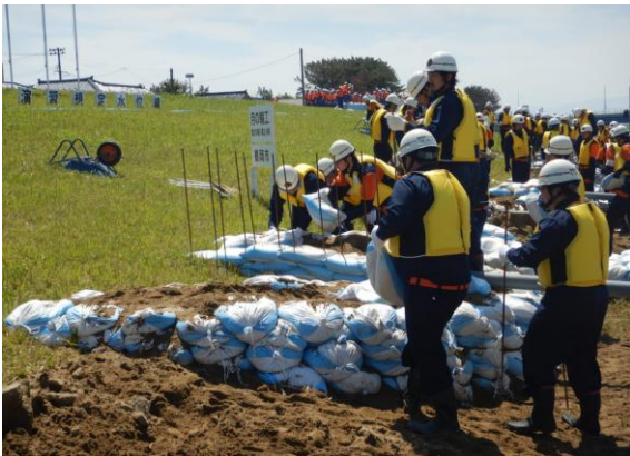
水防工法訓練（月の輪工） （最上川下流・赤川総合水防演習）
