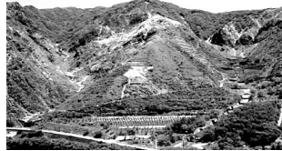
山腹工の採用によるCO 2 固定
