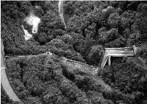
祭時大橋 (岩手県一関市)
