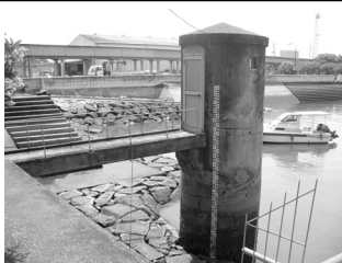
潮位計等の観測施設の設置
