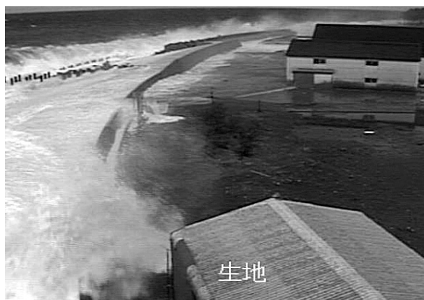
越波の状況 (富山県黒部市生地地区)
