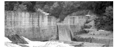
コンクリート砂防えん堤
