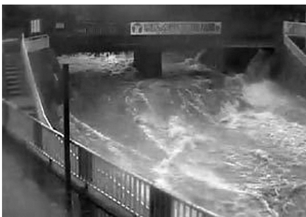
都賀川の出水状況
