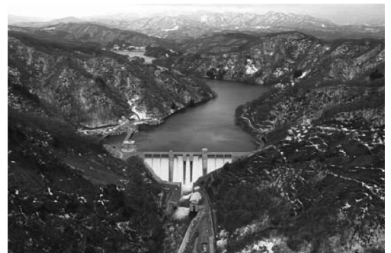
写真3 完成した横川ダム
