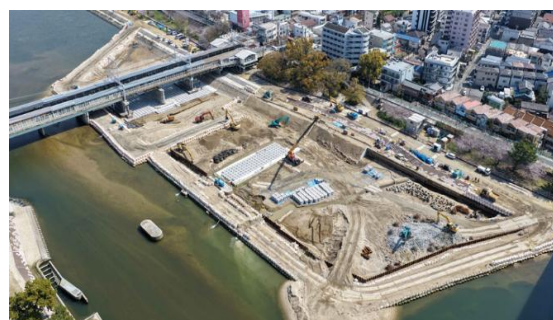
武庫川(尼崎市・西宮市)改修状況 (近畿大会兵庫県)
