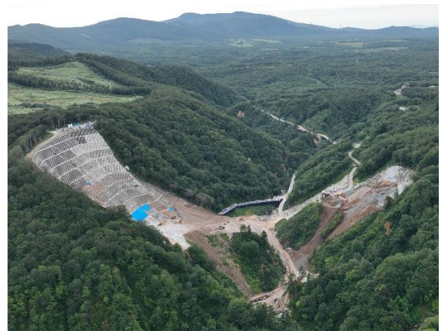
駒込ダム工事状況(令和8年8月26日)
