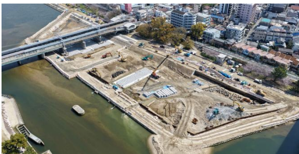
武庫川（尼崎市・西宮市）改修状況
