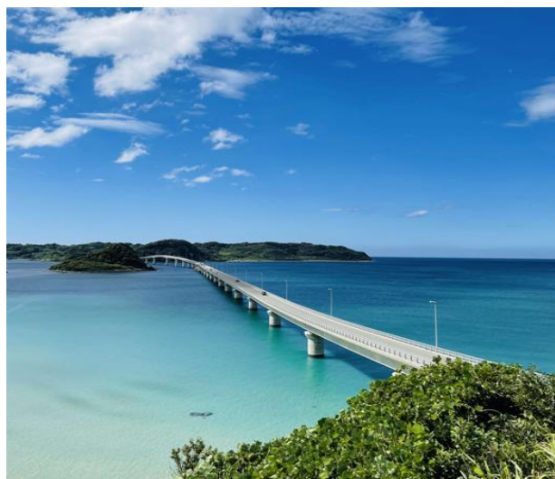
＜角島大橋（下関市）＞
