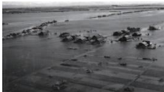
▲伊勢湾台風により冠水した新川河口付近（名古屋市港区南陽町）
