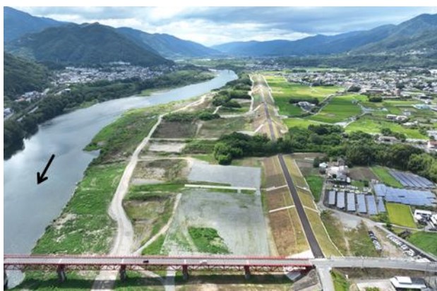
完成した吉野川・沼田地区の堤防
