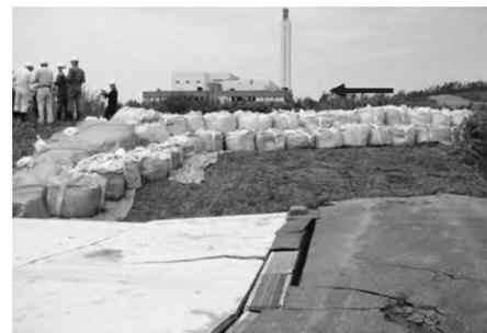
大型土のうによる応急復旧
