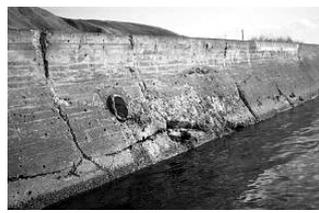
堤防の表法被覆工が損傷
