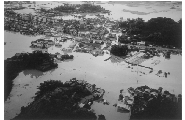
50年台風5号土佐市内の浸水状況
