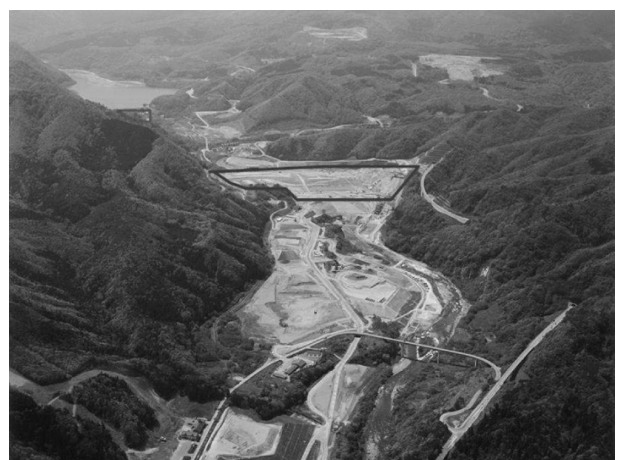
胆沢ダム：19年5月16日現在の進捗状況
