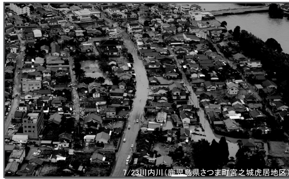
主な被害箇所
