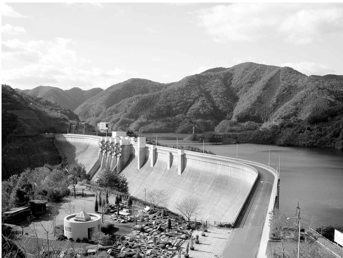
小瀬川水系小瀬川弥栄ダム (中国地方整備局提供)
