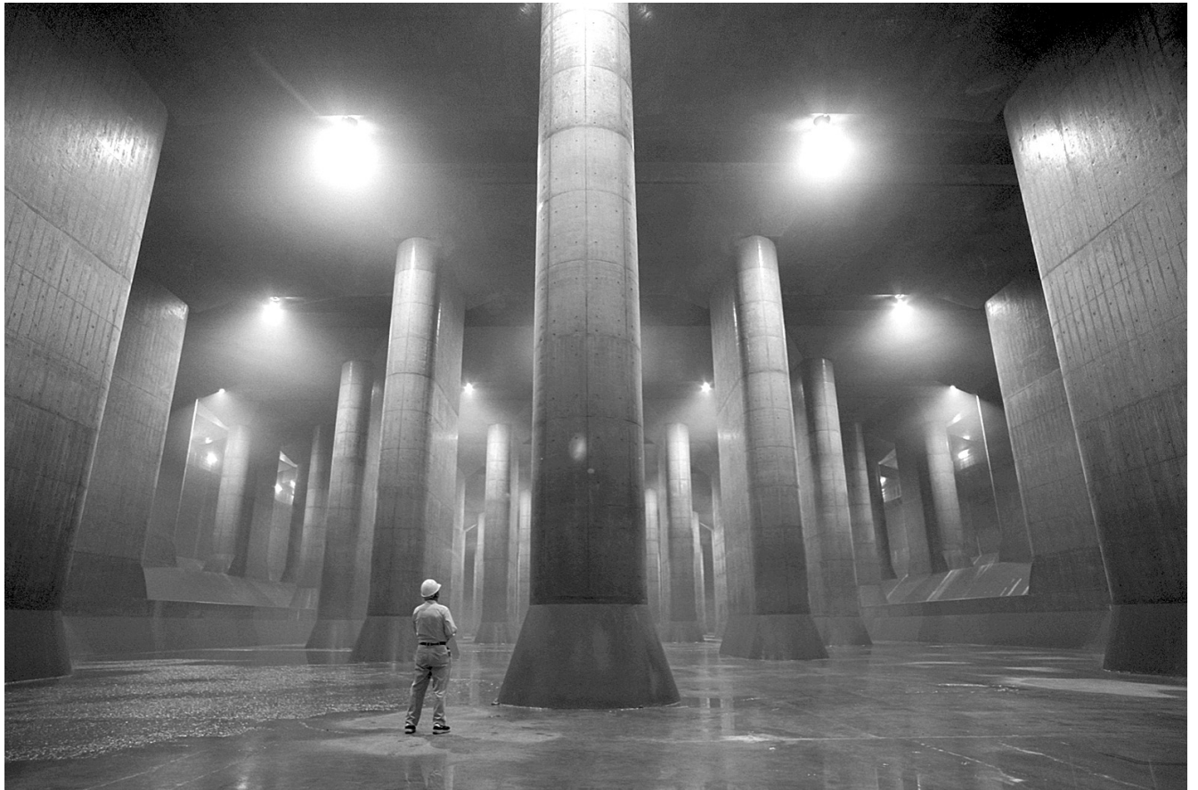
首都圏外郭放水路の調圧水槽 (関東地方整備局江戸川河川事務所提供)
