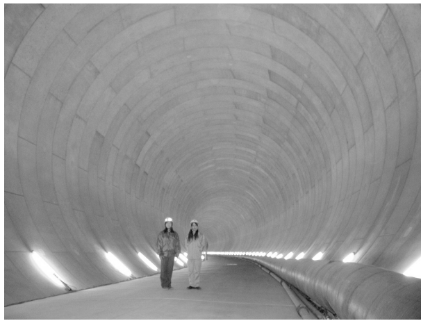
写真1 第4工区トンネル
