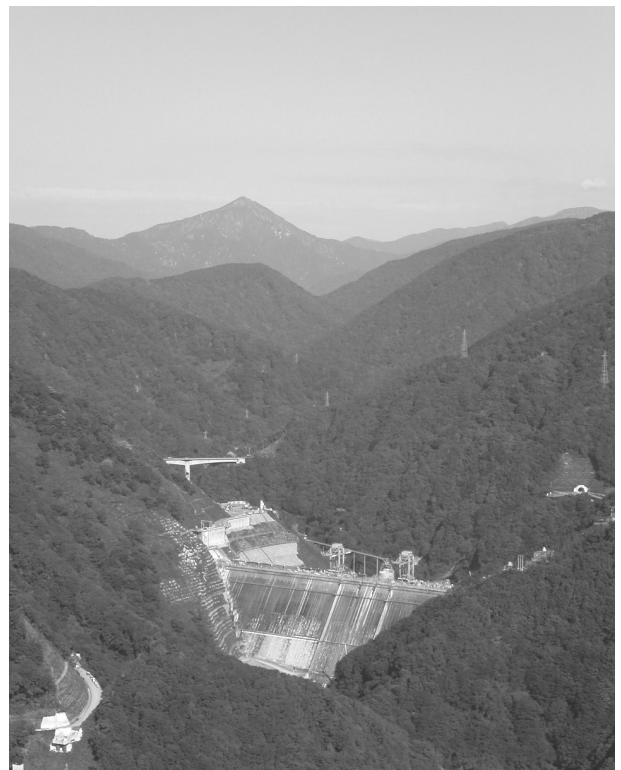
コンクリート打設100万㎡に達した長井ダム
