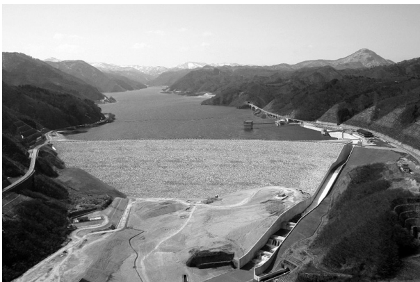
完成した摺上川ダム
