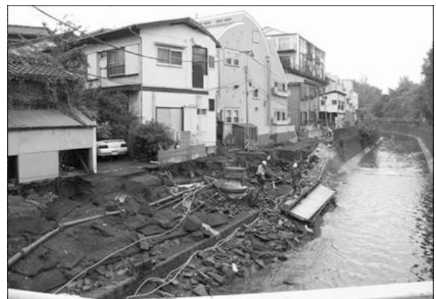
平成17年9月の東京集中豪雨による被災状況 (中野区・妙正寺川)
