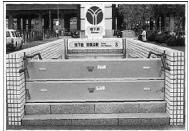
図2 止水板の設置
