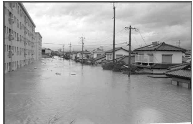
平成17年台風14号による浸水状況 (宮崎市小松地区・大淀川水系大谷川)
