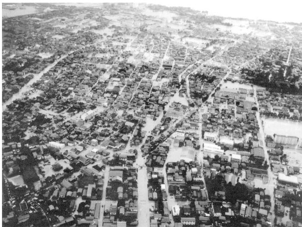
平成16年7月新潟・福島豪雨災害による浸水状況 (新潟県三条市)
