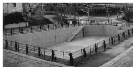
小規模な雨水貯留浸透施設の例
