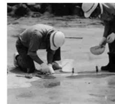
クラック補修状況 (注入工)
