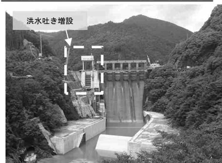
那賀川の洪水被害の軽減、流水の正常な機能の維持を目的とし、既設ダムの洪水吐き増設等を実施。洪水吐き増設については平成 31 年度の完成に向けて事業を推進する。
