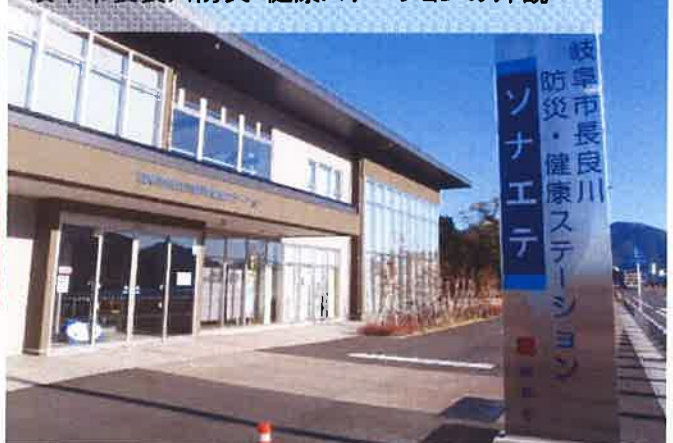
岐阜市長良川防災・健康ステーションの外観
