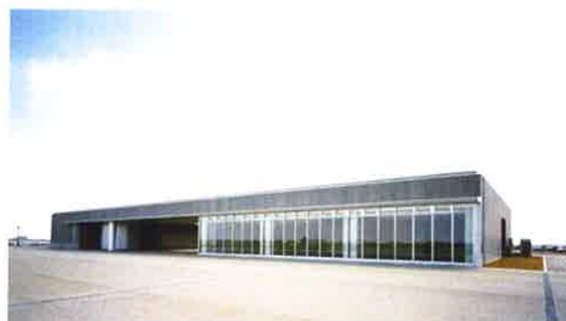
水防センター外観
