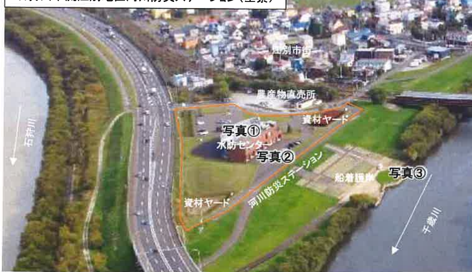
石狩川下流江別地区河川防災ステーション(全景)
