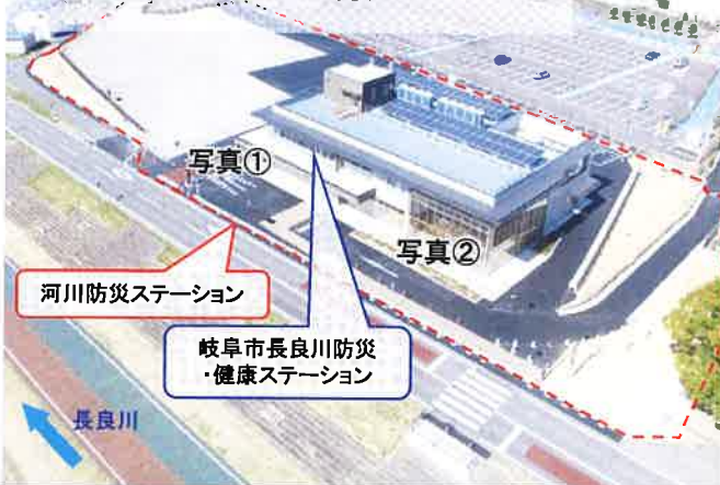
河川防災ステーションの現況
