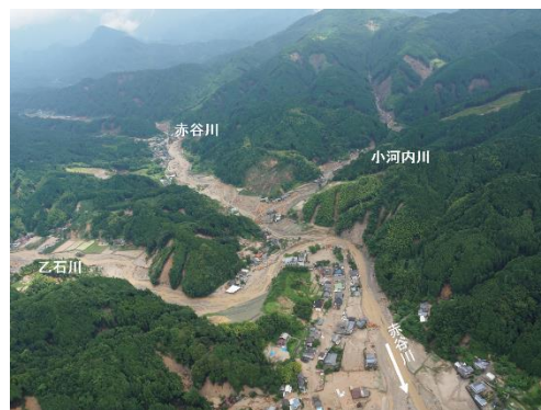
図 3.2.57 2017年の九州北部豪雨による被害福岡県朝倉市の赤谷川、小河内川、乙石川合流点付近における流木による被害(7月8日撮影)出典: 国土交通省(2017d)
