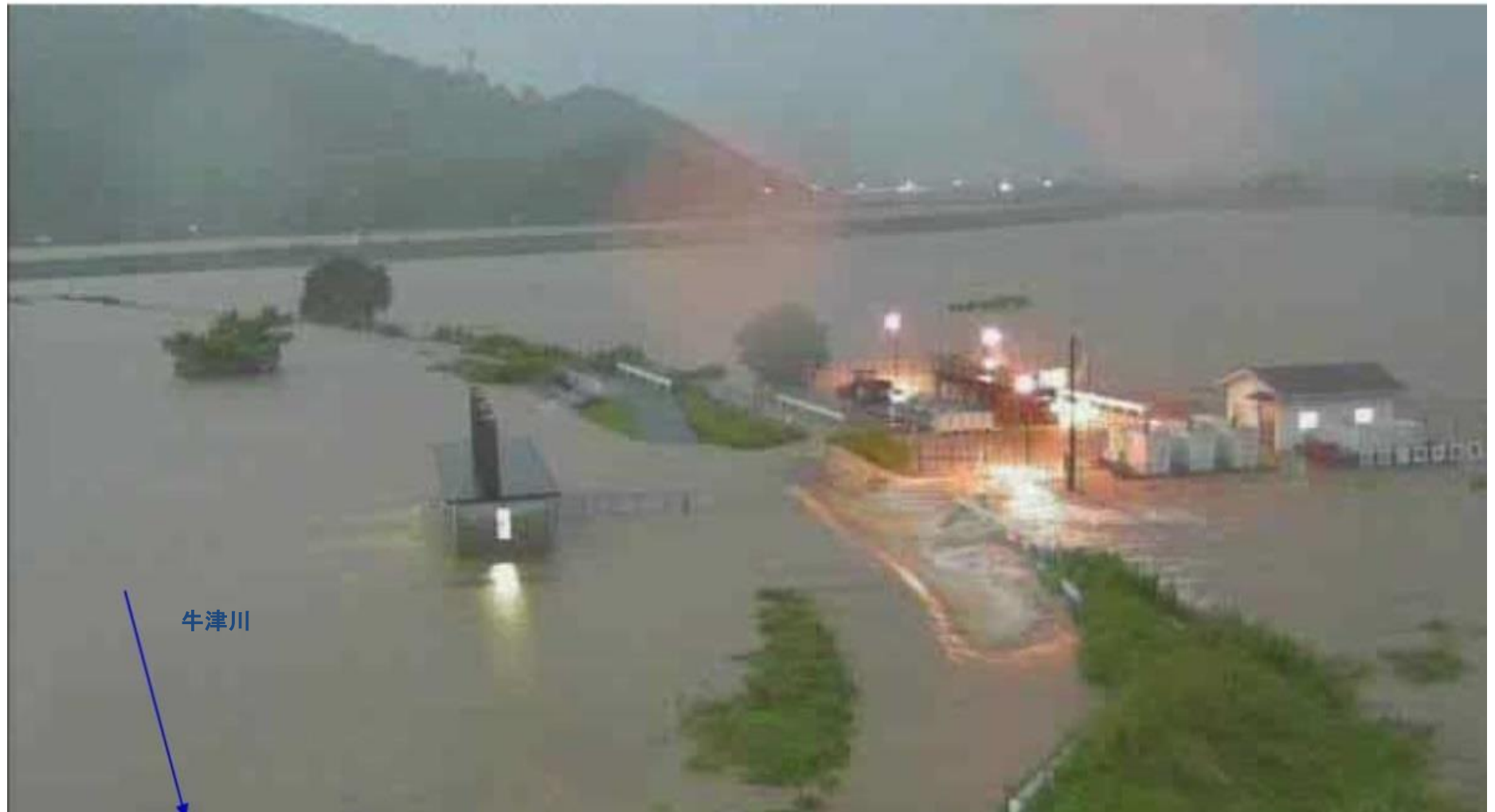
池田川排水機場付近より多久市側(牛津川越水状況)
