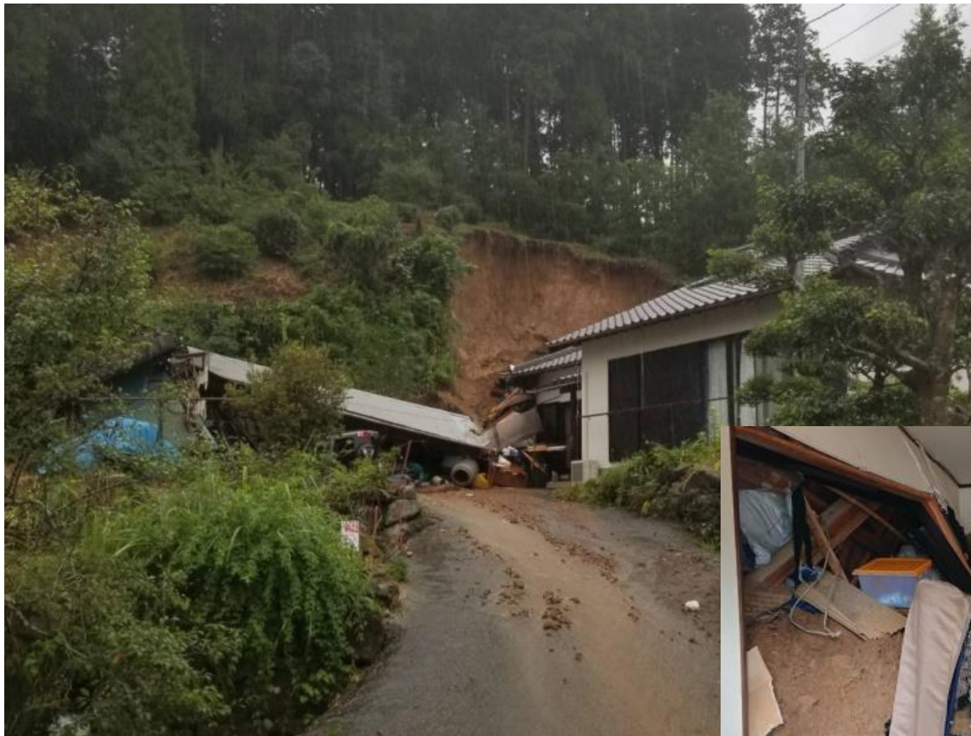
藤の川内地区土砂崩落
