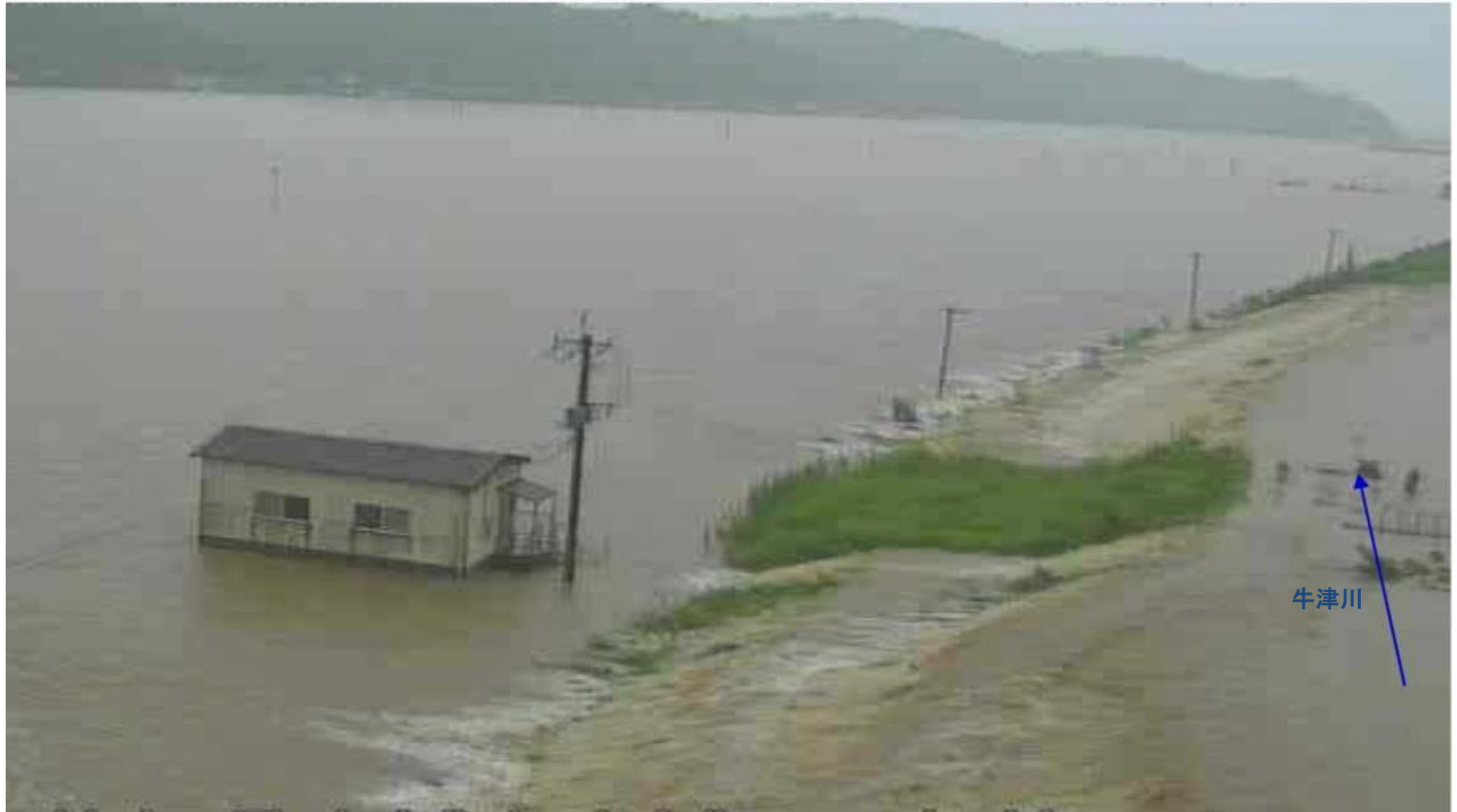
池田川排水機場付近から小城市側(牛津川越水状況)
