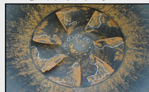
腐食した排水ポンプ場の羽根車
