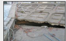
クラックが生じた河川護岸
