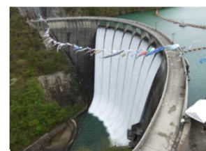
すだれ放流イベント（鳴子ダム）
