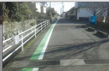
区画線の設置・カラー舗装
