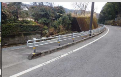
防護柵の設置
