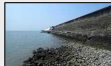
老朽化した海岸堤防
