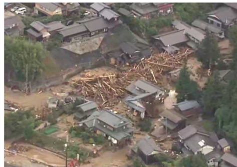
土石流等による被害 (新潟県村上市)
