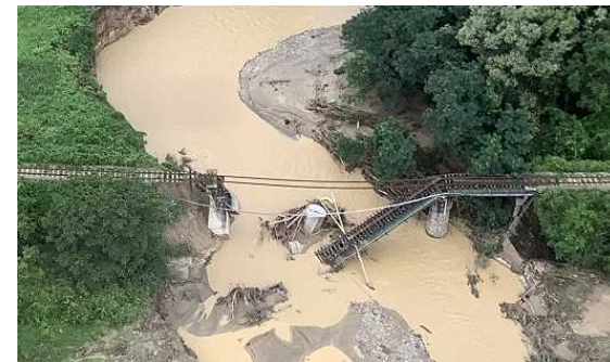
JR東日本・米坂線 橋梁倒壊 (山形県西置賜郡飯豊町)
