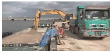
淀川左岸線工事における船舶の利用
