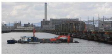
橋梁架替工事における船舶の利用
