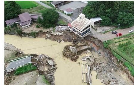
主要地方道長井飯豊線 橋梁崩壊 (山形県西置賜郡飯豊町)
