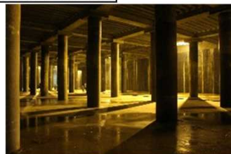
大規模地下貯留施設
