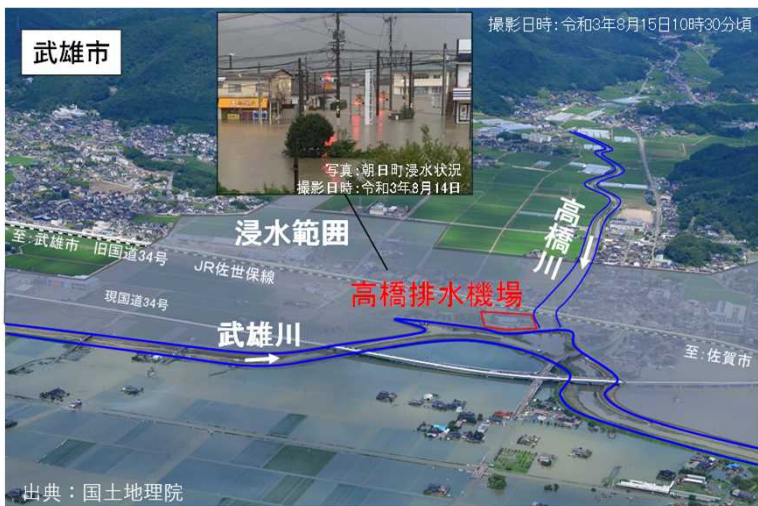
出典：国土地理院 令和3年8月の大雨による武雄市(佐賀県)の内水被害
