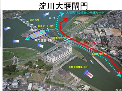
淀川大堰閘門
