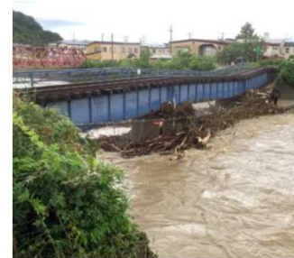
JR東日本・五能線 橋梁傾斜 (青森県西津軽郡鰺ヶ沢町)
