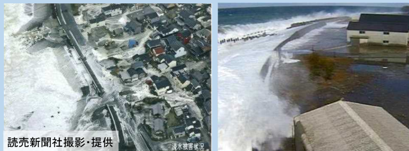
高波による越波・浸水状況
