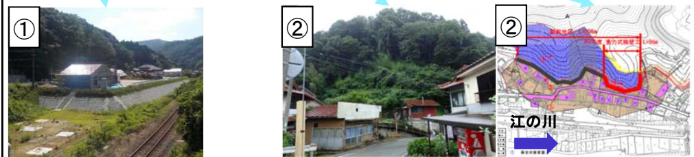
河川事業①と砂防事業②で連携して実施する防災対策
