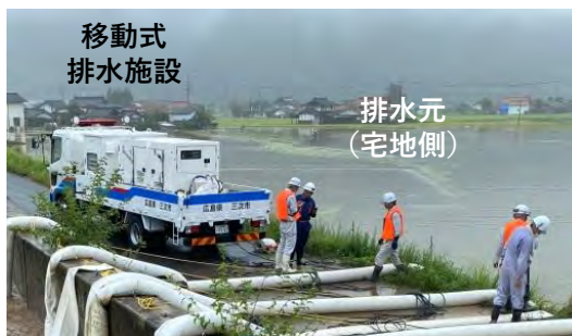
樋管のゲートにポンプを設置
