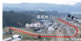
移転家屋の建設が進む状況
