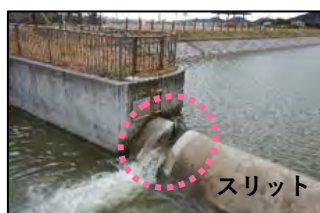
▲スリットの設置状況
