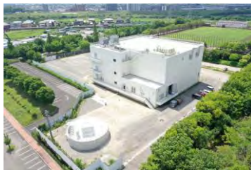
雨水ポンプ場
