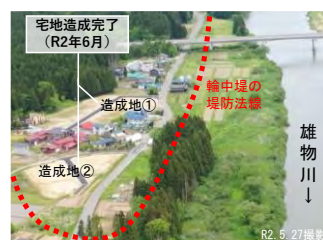
移転先宅地造成完了状況
