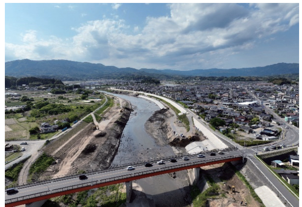
夏井川改良復旧事業状況(いわき市)
