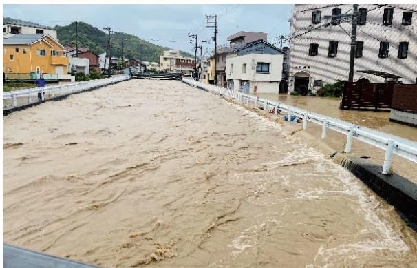
令和5年6月梅雨前線及び台風第2号の豪雨 日方川の浸水状況(海南市)
