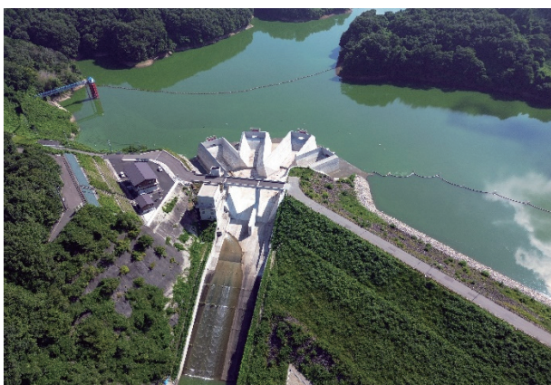
千五沢ダムの工事状況(石川町)
