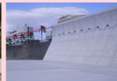
海岸保全施設整備
