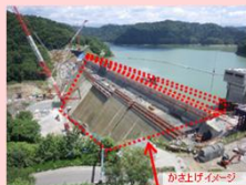
ダム建設・再生
