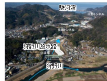
狩野川水系狩野川 狩野川放水路の改造
