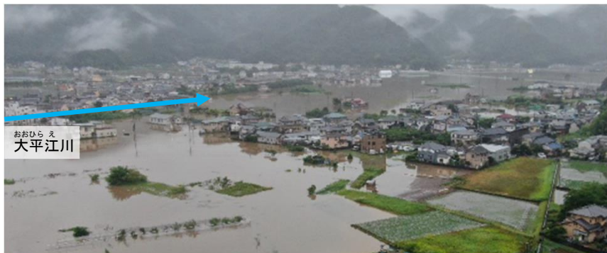
令和6年6月の大雨(静岡県沼津市)
