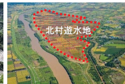
令和6年3月完成
