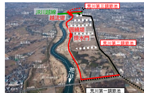
荒川第二、三調節池の整備
