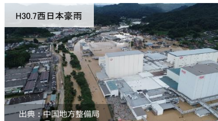
コカコーラ工場が浸水状況 (広島県三原市)
