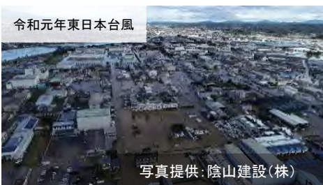
郡山中央工業団地の浸水状況 （福島県郡山市）
