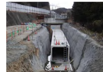
大野導水路 併設水路工事状況
