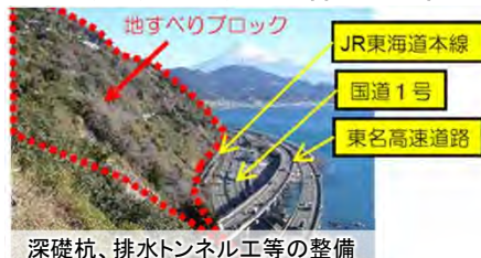
深礎杭、排水トンネル工等の整備
