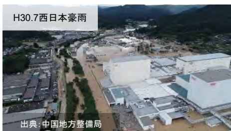
コカコーラ工場の浸水状況 （広島県三原市）
