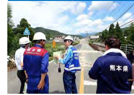
土木研究所職員による技術的助言(熊本県宇城市)
