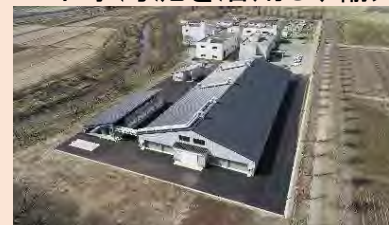
秋田県県南地区 広域汚泥資源化施設 (令和7年4月稼働開始)
