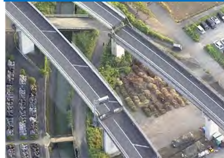
防災ヘリによる被災状況調査(熊本県八代市)
