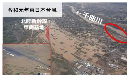
北陸新幹線の車両基地の浸水状況 （長野県長野市）
