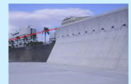
海岸保全施設整備
