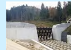
砂防関係施設整備
