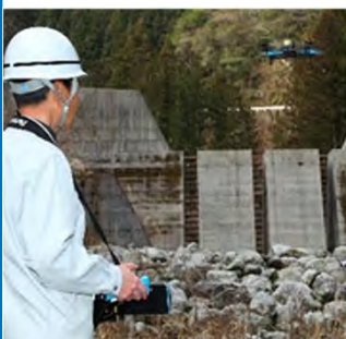
UAVを用いた点検高度化
