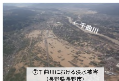
【令和元年東日本台風】
