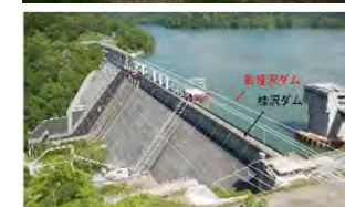
例：幾春別川総合 開発事業 新桂沢ダム (桂沢ダムを嵩上げ)
