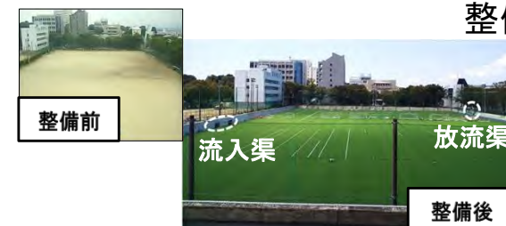
久留米大学の校庭を利用した流域貯留施設 (筑後川水系下弓削川・江川)
