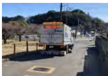
(空洞探査車による調査)
