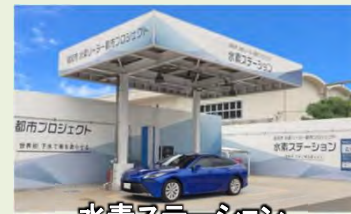
水素ステーション
